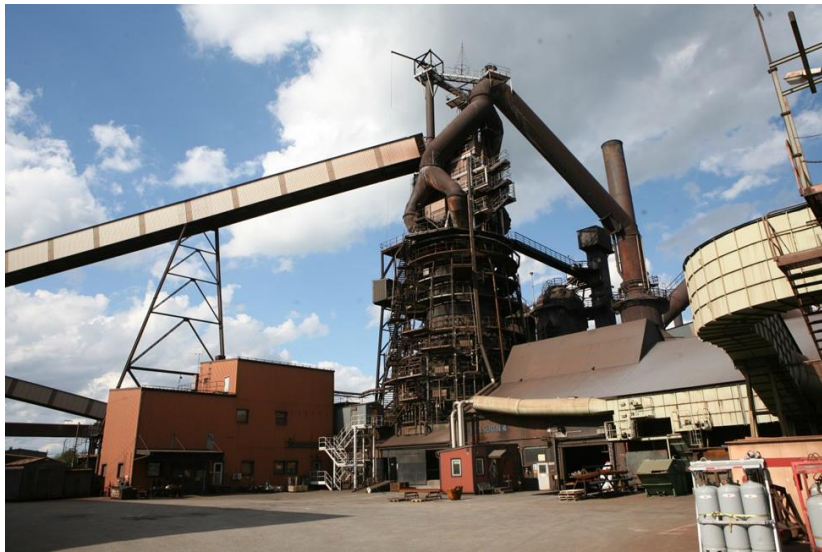
Fig 1. SSAB Oxelösund blast furnace Sweden. Courtesy of Erik Olsson.
